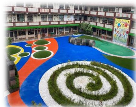
內集合場多功能地坪改善工程
