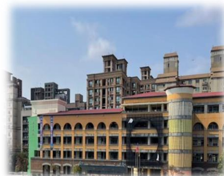
建置全校各建物之防水隔熱屋頂
